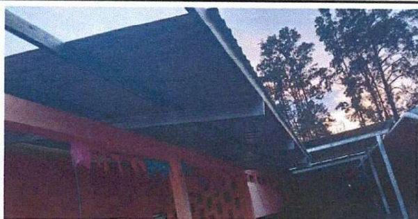
Foto 5: Colocacion de laminado
