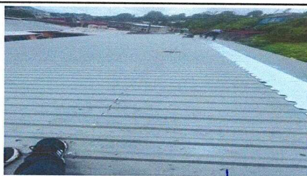
Foto 6 Culminación de la colocación de láminas.
